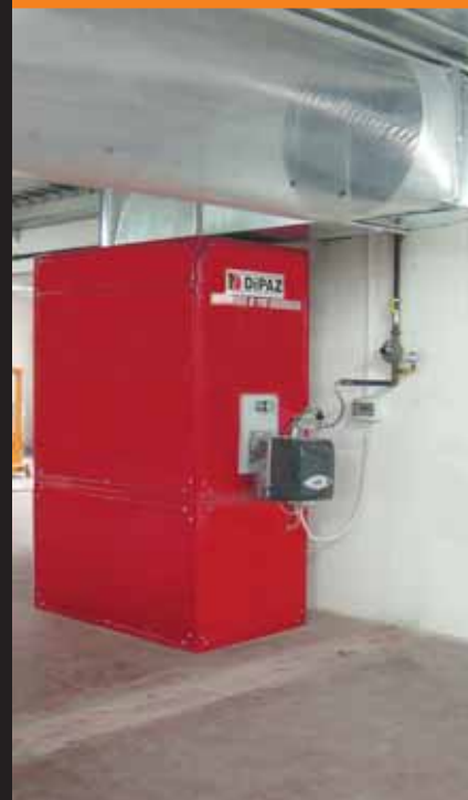
Tekstil Atölyesinde Hava Kanalı Bağlantılı
